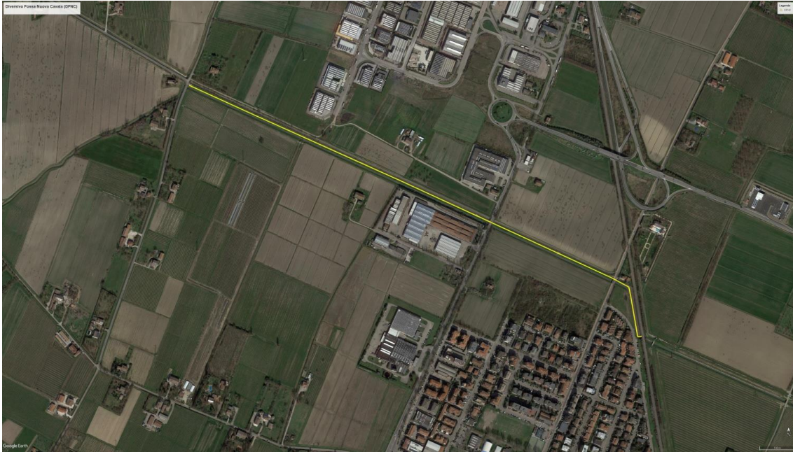
Figura 11 - Tratto di intervento lungo il Diversivo Fossa Nuova Cavata (in giallo)
